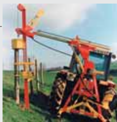
Les travaux en dévers sont possibles, mais demandent plus de vigilance.
